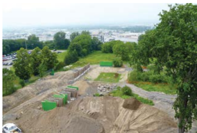
Figure 18.2 Contrôle de l'érosion
