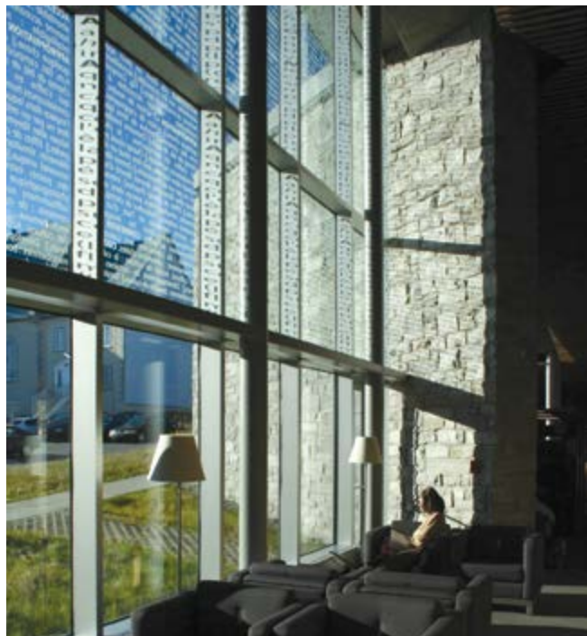
Figure 6.8b Occultation par sérigraphie sur verre
