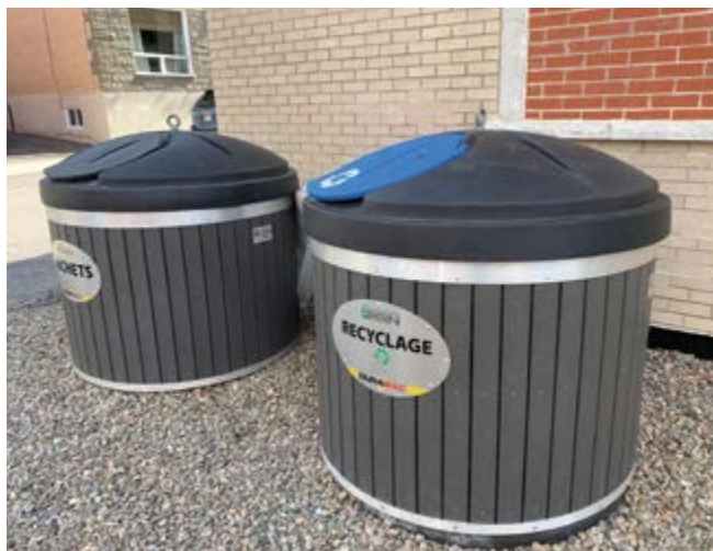
Figure 13.3 Bacs de récupération des matières résiduelles semi-enfouis
