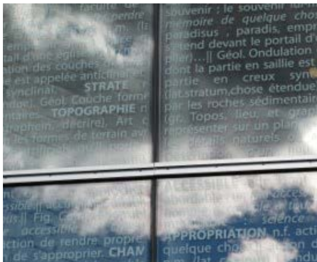
Figure 6.8a Occultation solaire par sérigraphie sur verre
