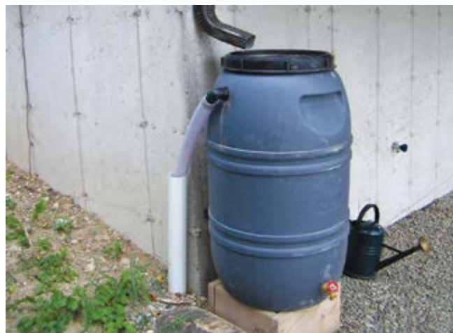
Figure 19.2 Citerne de rétention des eaux de pluie
