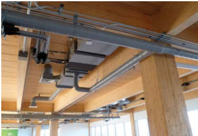
Figure 7.3 Considération acoustique dans une structure apparente
